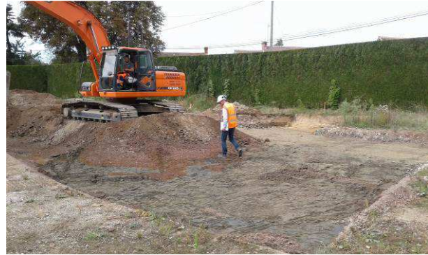
Suite des terrassements
