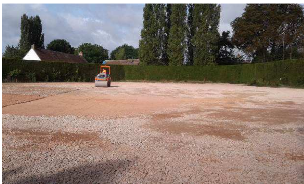
Compactage du remblais positionnés
