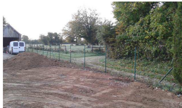
Réfection de la clôture
