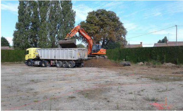
Chargement en direct des terres vers l'ISDND des Ventes de Bourse
