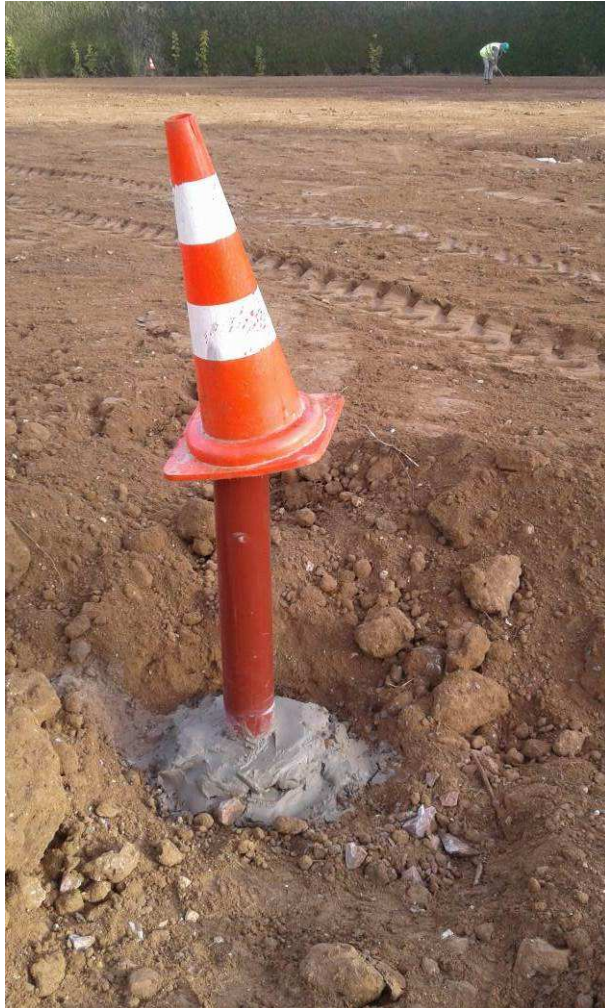
Sécurisation des piézomètres
