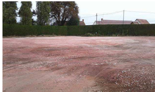
Mise en place du remblais sur les zones excavées
