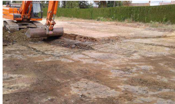
Terrassement en « terrasse » pour l'optimisation des volumes
