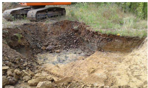
Terrassement et mise à jour d'impact
