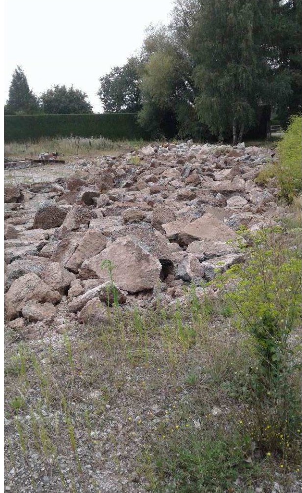
Démolition des dalles bétons restantes
