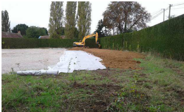
Mise en place géotextile et apport de terre végétale
