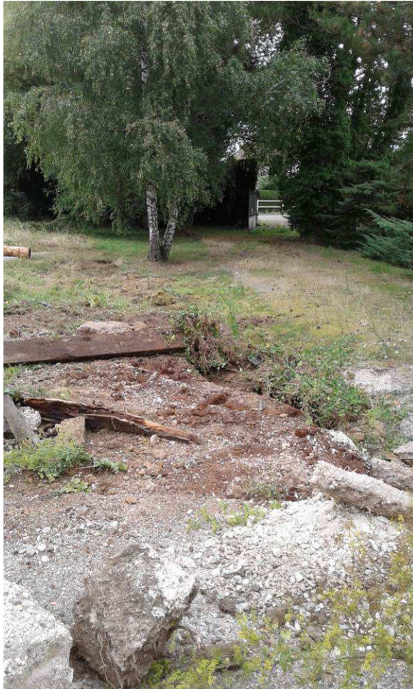
Démolition des IPN présents sur site
