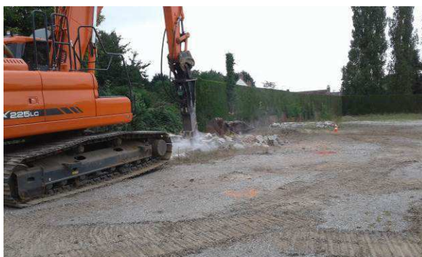
Démolition des rampes de l'ancien pont bascule
